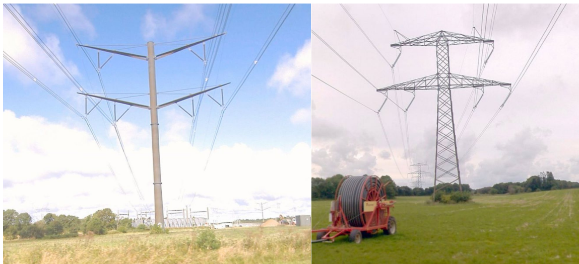
Figur 4-2. Illustration af de nye master, som opsættes (tv. Eagle-mast og th. Donau-mast). De er lig dem, som findes i området i dag. Billederne er af gennemløbsmaster.
