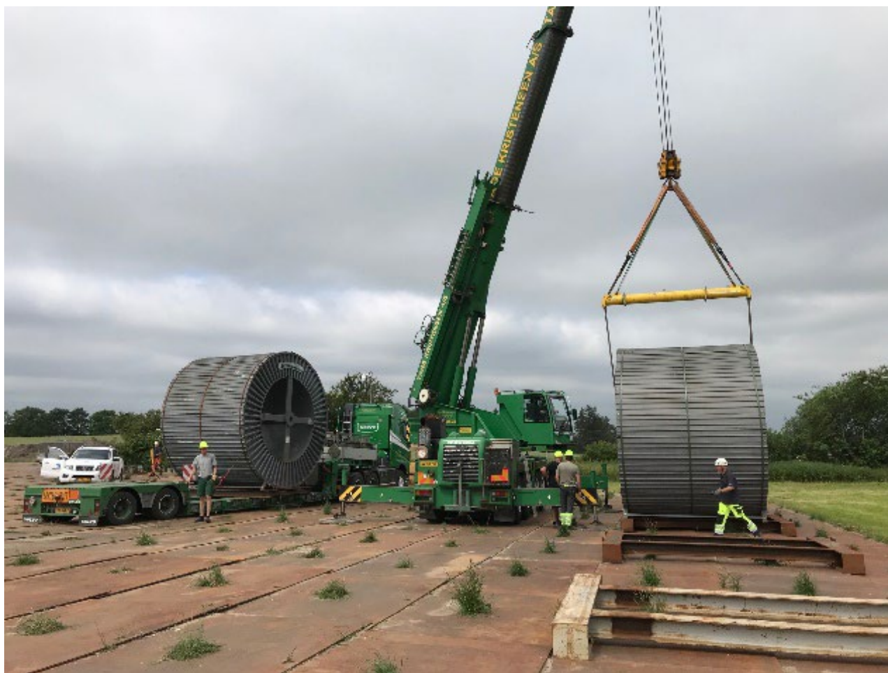
Figur 3-13. Håndtering af kabeltromler på tromleplads.
