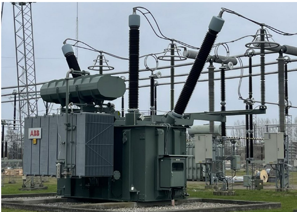
Figur 2-4. Eksempel på en kompenseringsspole (reaktor).
