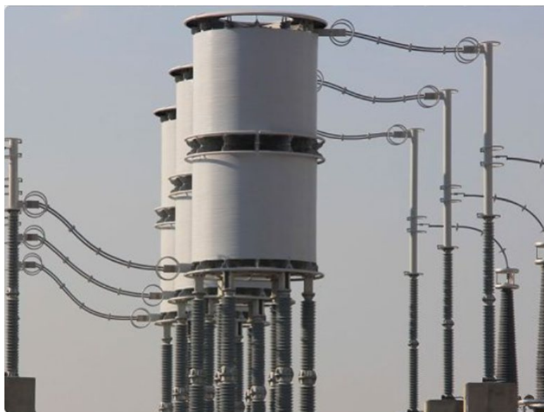
Figur 2-3. Eksempel på seriereaktanser, der indgår i et seriereaktansanlæg.
