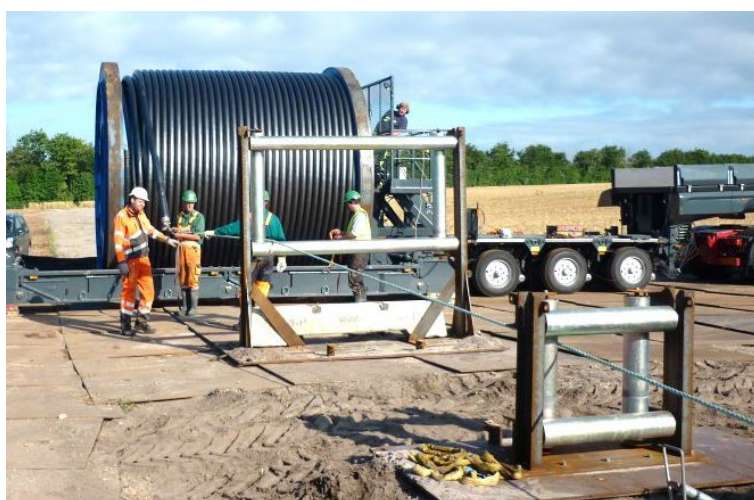
Figur 3-9. Kabeltromle på blokvogn.
