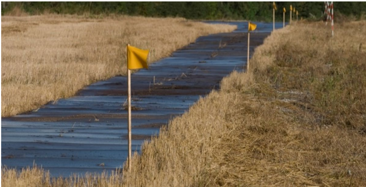
Figur 3-12. Adgangsvej med køreplader.
