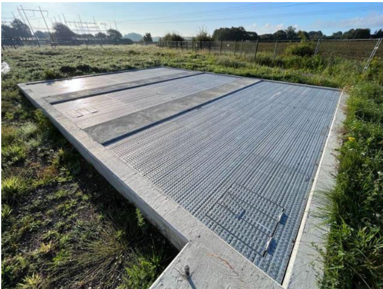
Figur 2-5. Fundament/kar, som det ser ud, inden transformer eller kompenseringspole (reaktor) placeres ovenpå.
