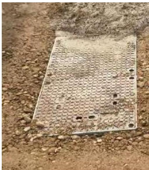
Figur 3-3. Eksempel på fiberbrønd i terræn.
