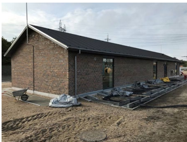
Figur 2-9. Eksempel på en manøvrebbygning.
