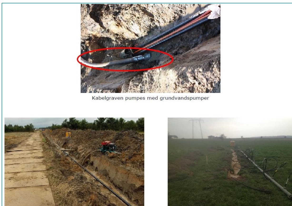
Figur 3-80. Forskellige metoder til at holde kabelgraven tør. På billedet til venstre etableres drænrør, til højre etableres sugespidsanlæg.
